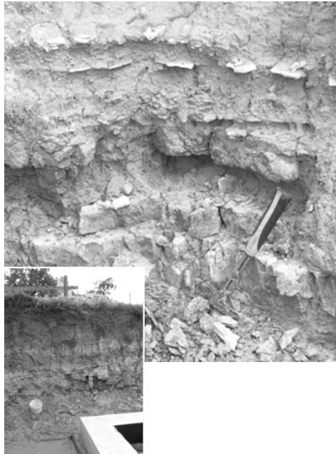
Rys. 3. Utwory pstrego piaskowca w wykopie fundamentowym w Chorzowie Starym
