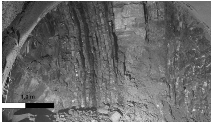
Fot. 1. Seria skalna łupkowo-piaskowcowa w przodku na trasie tunelu ewakuacyjnego w Lalikach (fot. Z. Niedbalski)
