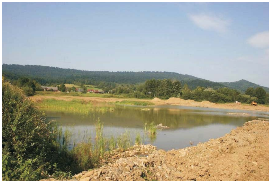
Fot. 2. Eksploatacja odkrywkowa złoża Trzciana II – pole B (fot. A. Kowalska)
